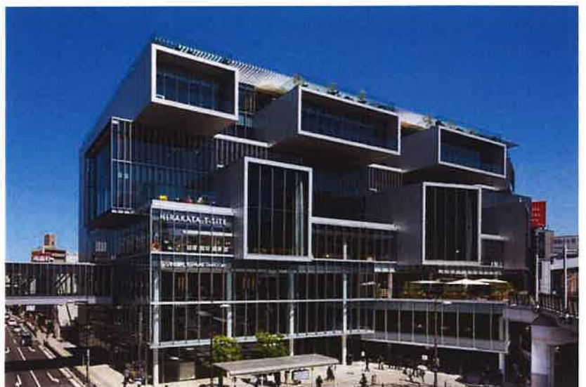
駅前広場に面して開放的なファサード
