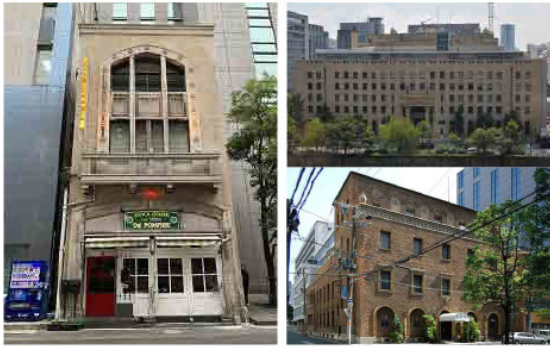
左：今橋ビルディング（現ボンビエーレ）1925年竣工 旧大阪市中央消防署今橋出張所 右上：三井住友銀行本店 1930年に最終竣工 黄電山石外装 住友合資会社工作部 右下：大阪倶楽部 1923年竣工 安井武雄設計（初代会館は1914年竣工 木造）
